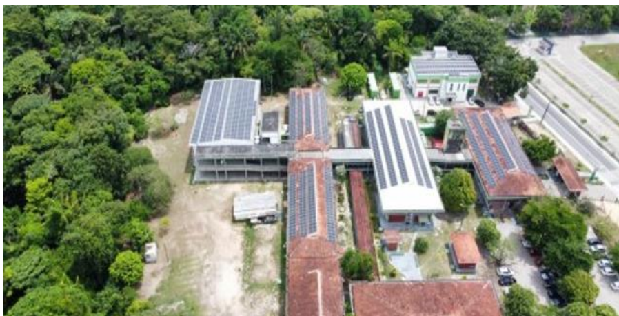
Figura 17 - Estudo do Local onde instalado os painéis solares
