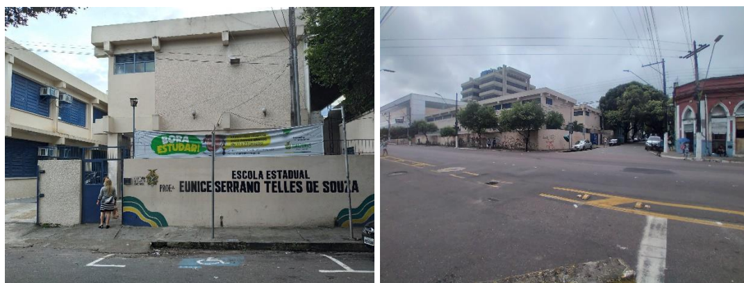
Figura 1: Escola Estadual Eunice Serrano Teles de Souza. Fonte: Próprio autor.
