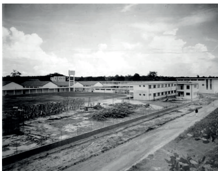
FIGURA 4: VISTA ÁREA DA CONSTRUÇÃO DA ESCOLA TÉCNICA FEDERAL DE MANAUS EM 1941, NA ANTIGA PRAÇA RIO BRANCO.
