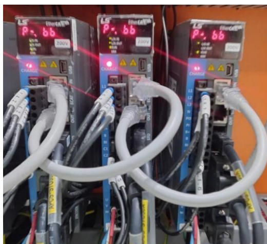
Figura 15 - Ligação da rede EtherCat nos servos amplificadores
