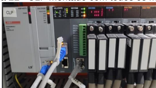
Figura 21 - CLP montado com todos os módulos
