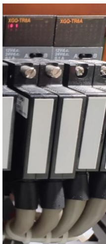
Figura 19 - Módulo de saída (XGQ-TR8A)
