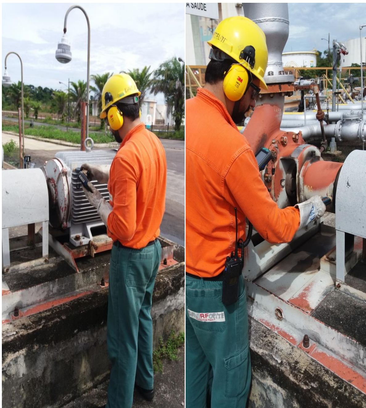
Figura 30 - Técnico de Operação coletando dados de vibração em bomba centrífuga (Fonte: Autor)
