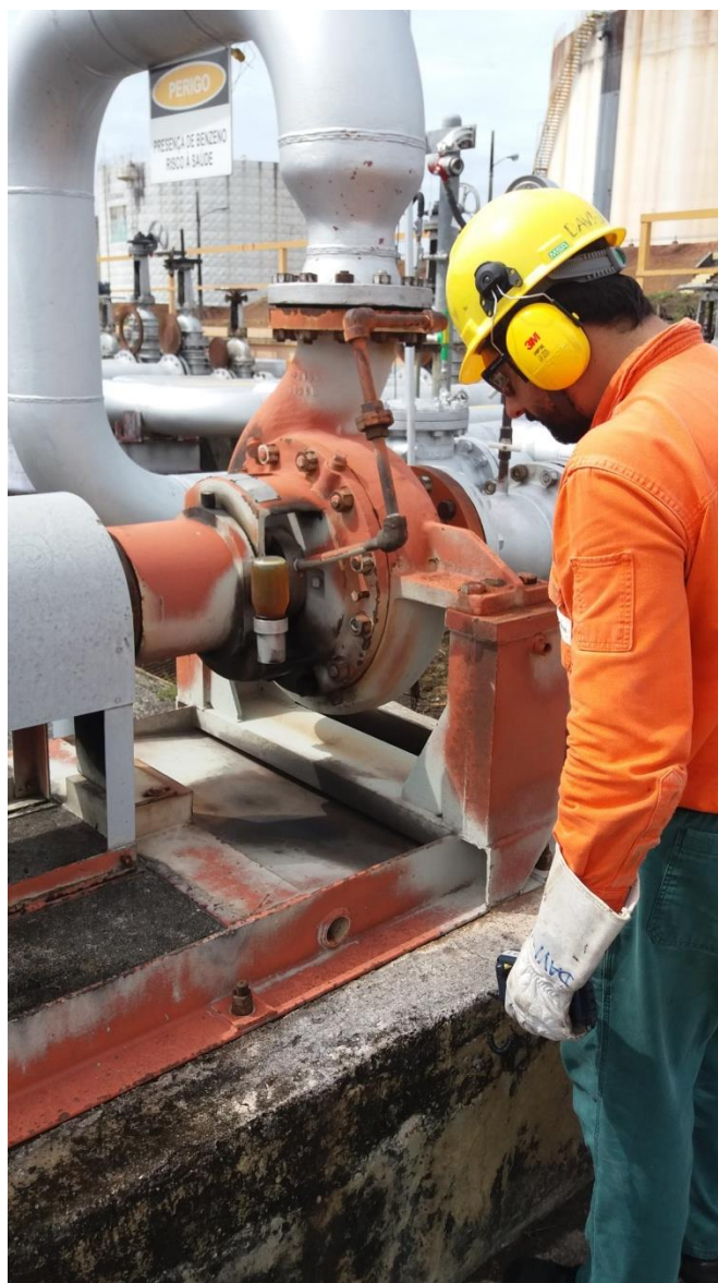
Figura 33 – Inspeção visual do aspecto do óleo lubrificante (Fonte: Autor)
