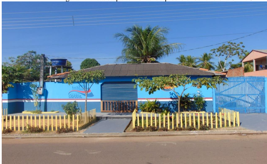
Figura 2: Vista da parte frontal do prédio onde funciona o PFJC
