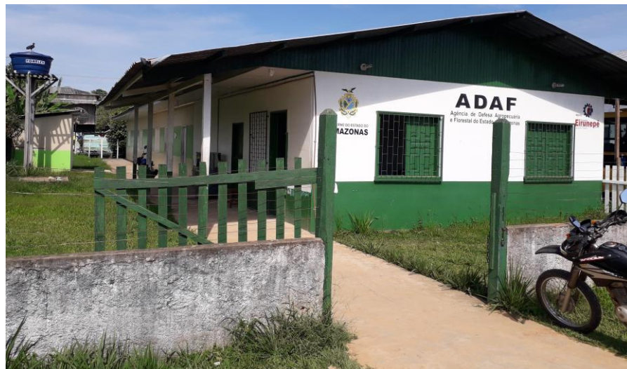
Figura 3 – IFAM prédio ADAF – bairro N. Sra. de Fátima
