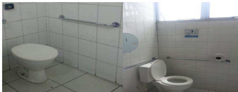
Figura 3 – Banheiro com barras de apoio
