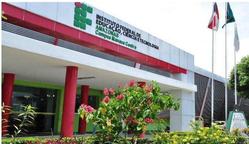
Figura 9 – Entrada principal do Campus Manaus Centro do IFAM
