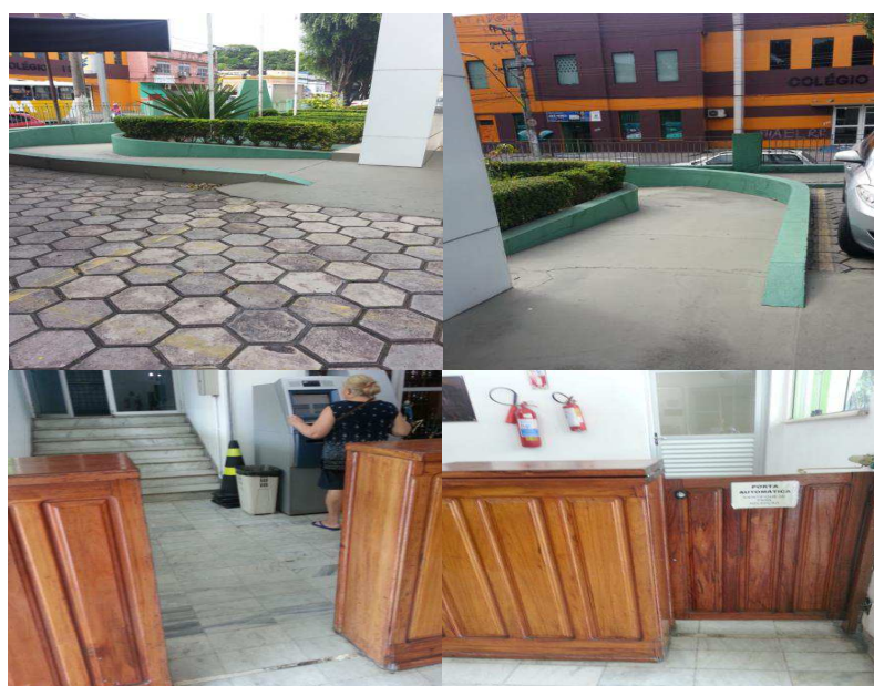
Figura 5 – Entrada principal do CMC
