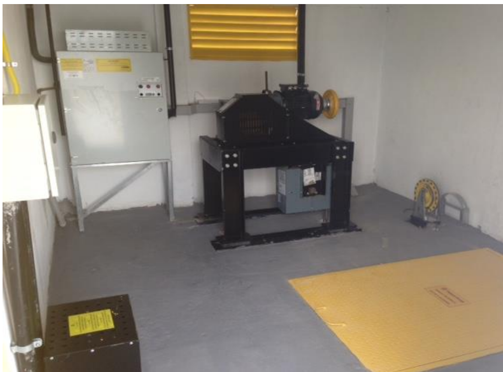
Figura 16- Casa de máquinas de 1 nível.
