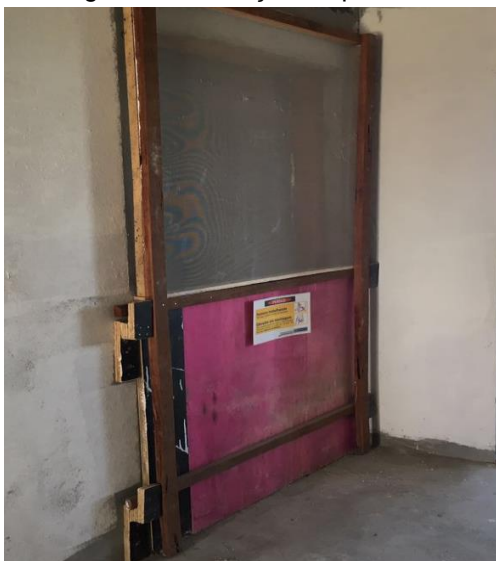
Figura 13- Proteção de pavimento.
