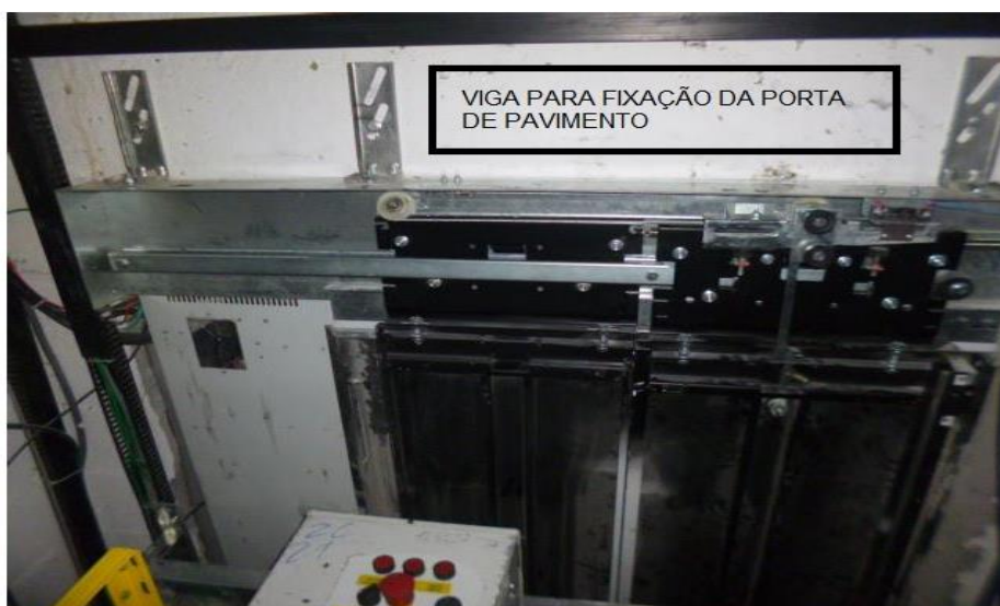
Figura 14- Foto da viga superior para fixação da porta de pavimento.
