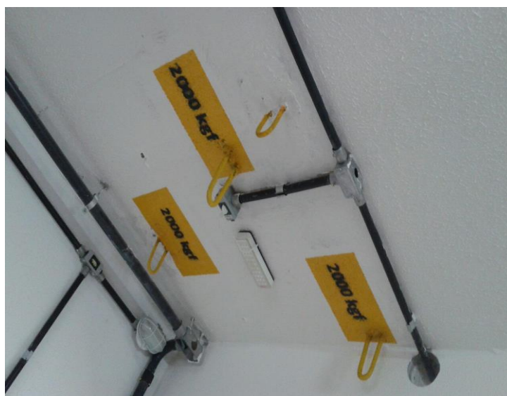
Figura 17- Detalhe dos ganchos da laje em obra.
