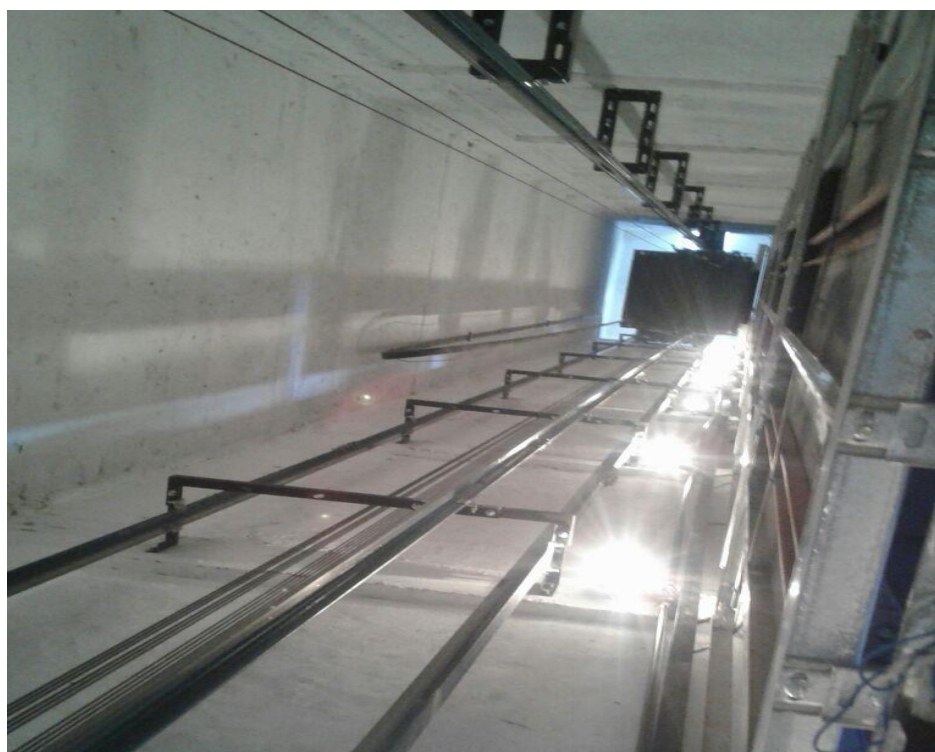
Figura 6- Caixa de corrida com componentes instalados.
