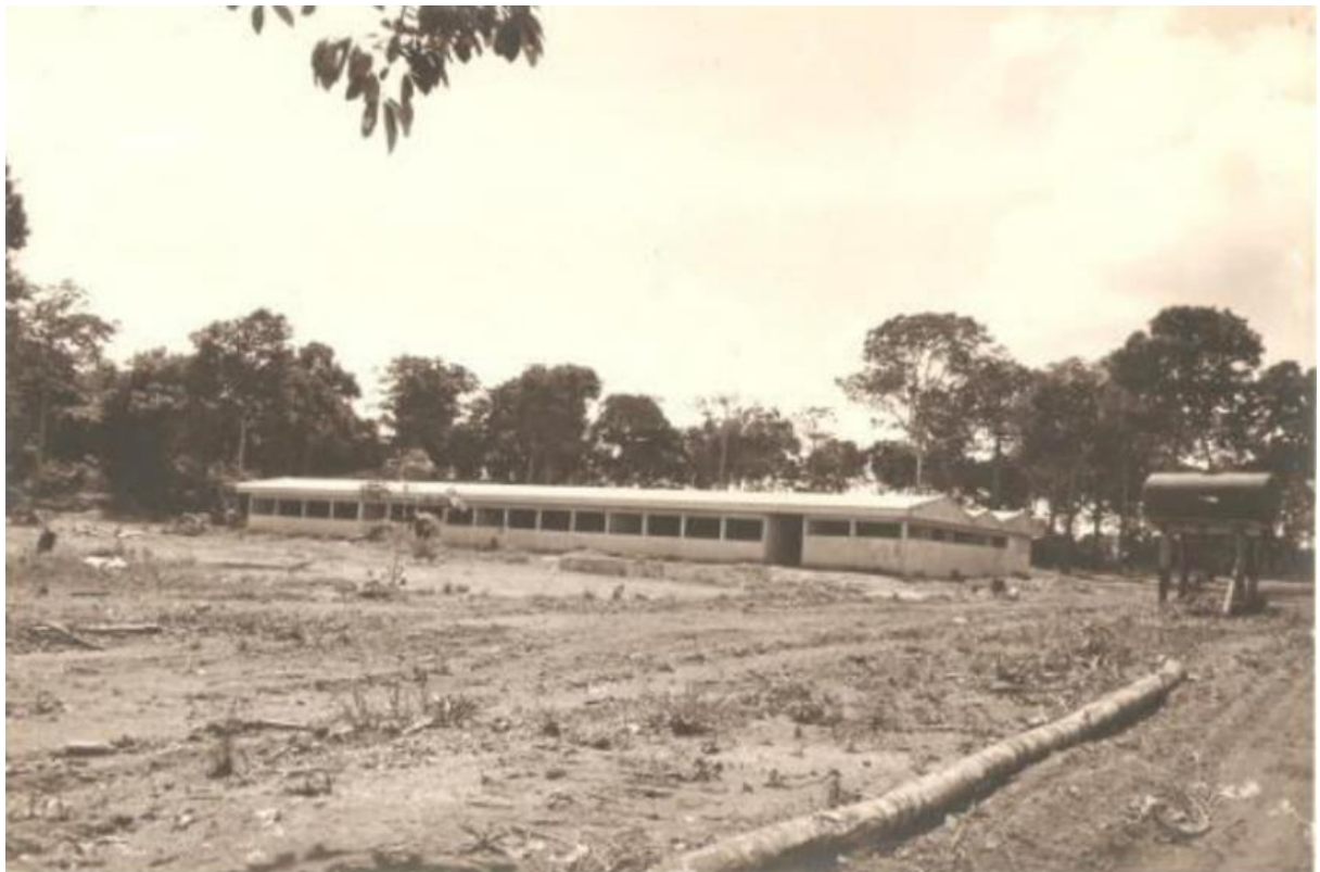
Figura 2: Construção do Colégio Agrícola do Amazonas (1970).
