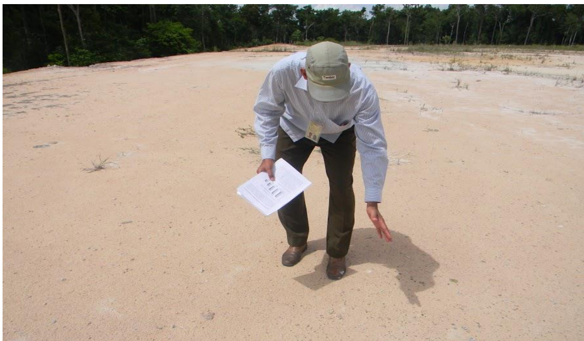
Figura 16 – Erosão laminar localizada na estrada do bairro de Puraquequara, no Distrito Industrial II.
