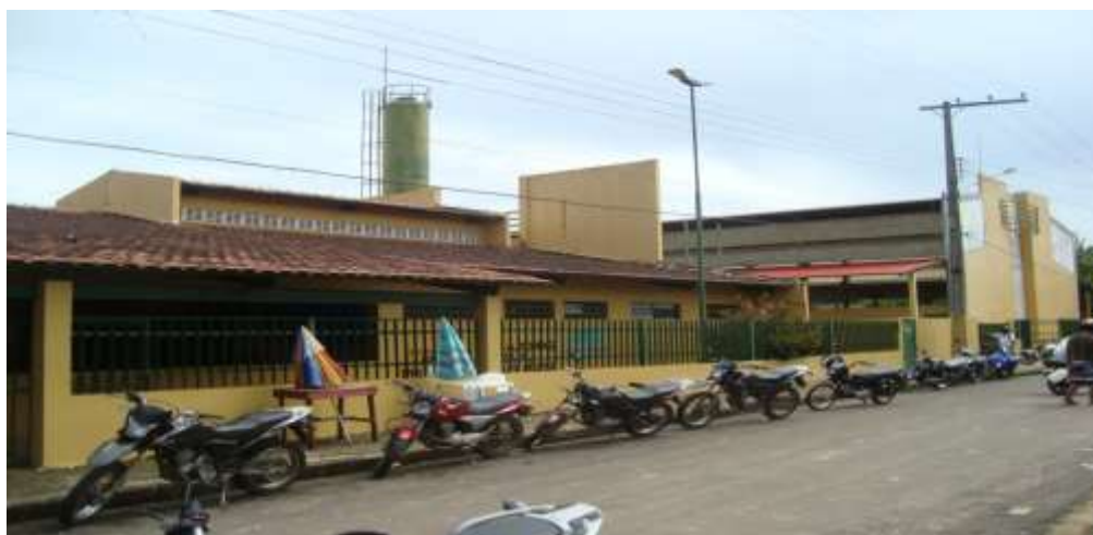
Figura 2 Rua Moacir Veiga da Gama onde se localiza a escola Nazira
