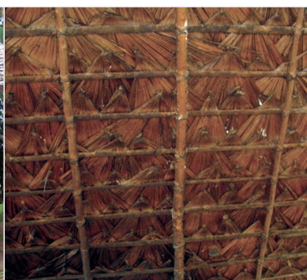
Utilização como caibro
