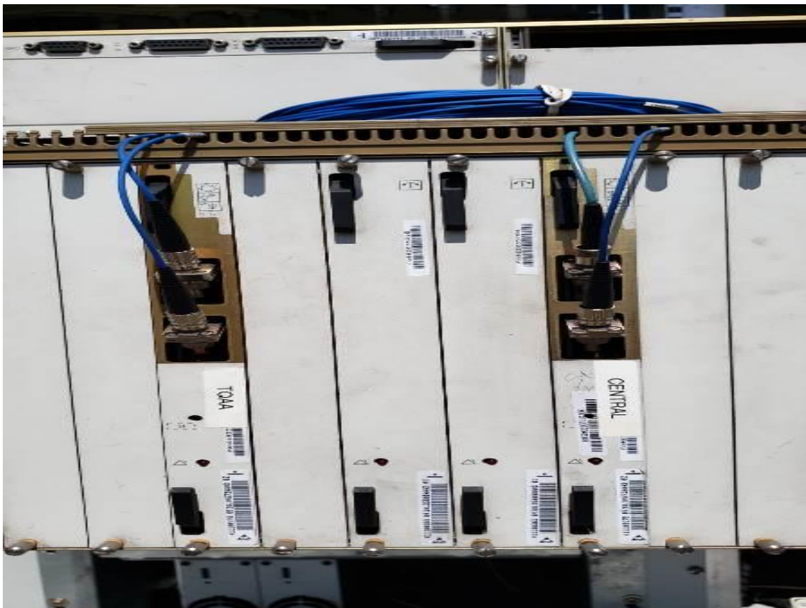
Figura 20 – Placa Óptica STM-1
