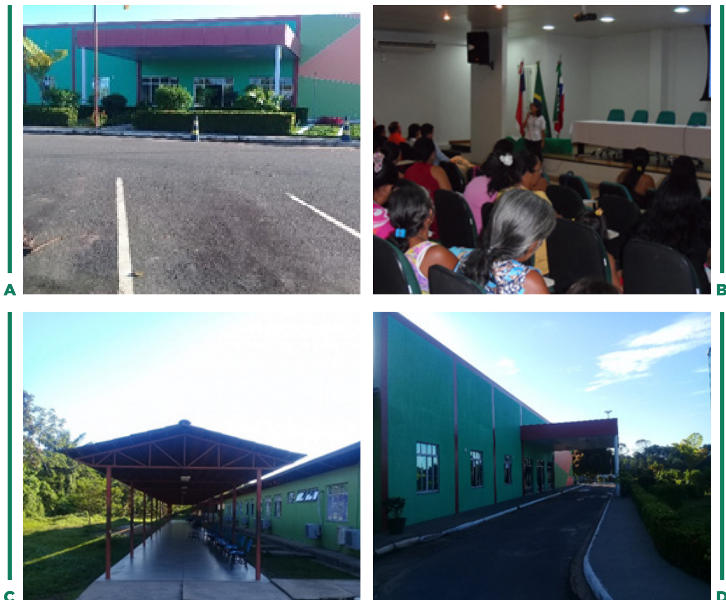
Imagem 04: Visão frontal do IFAM/CMA (A e D), Auditório (B) Visão latera – acesso (C)
