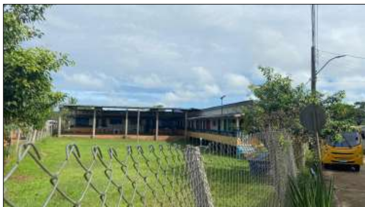
Figura 6 - Fachada da Escola Municipal José Salvador Braga
