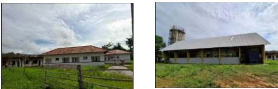
Figura 7- Novo prédio em construção e o ginásio escolar.
