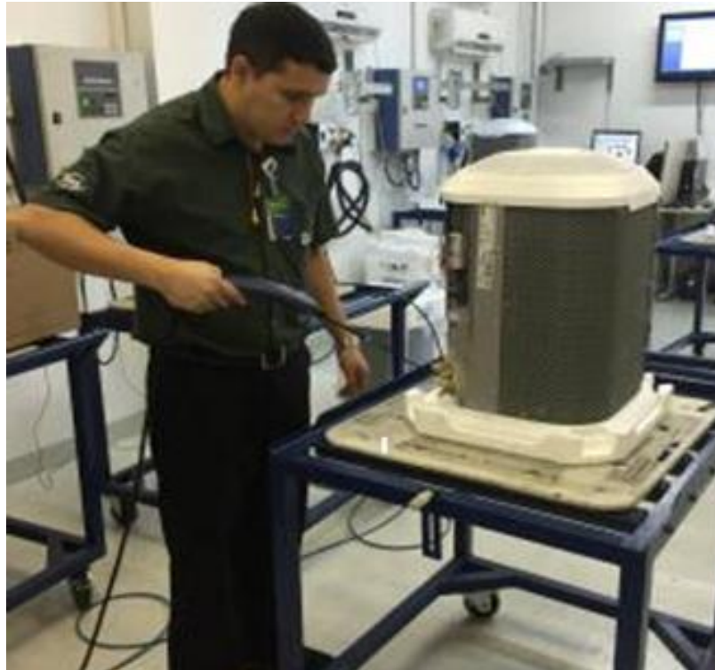
Figura 13 - Teste de vazamento de gás refrigerante com o Detector HDL 5000 Fonte - Autor: mar.2017
