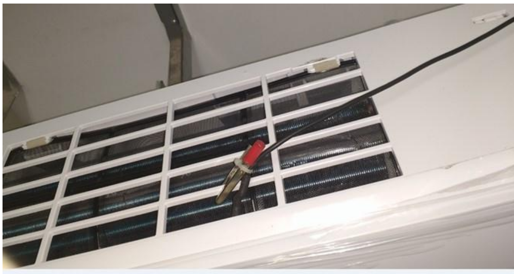
Figura 17 - Sensor de temperatura na entrada do evaporador (T2) Fonte - Autor: mar.2017
