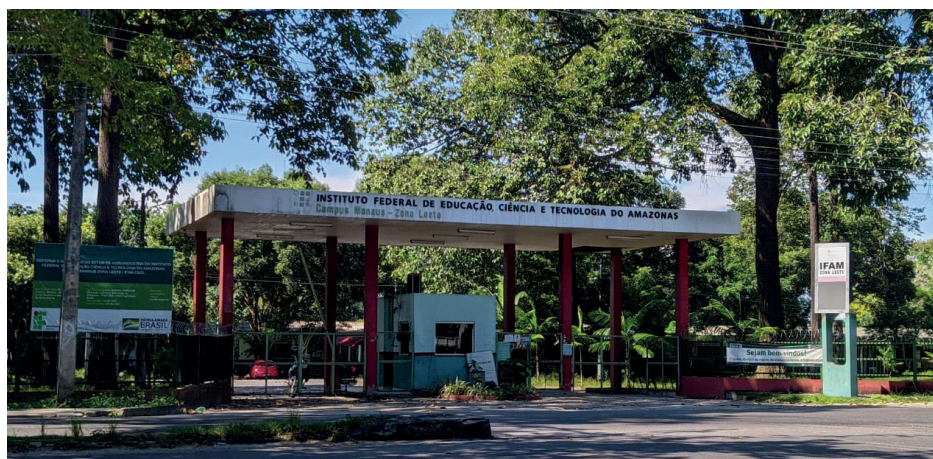
Figura 2 – Vista da Entrada do Campus Manaus Zona Leste (2021).
