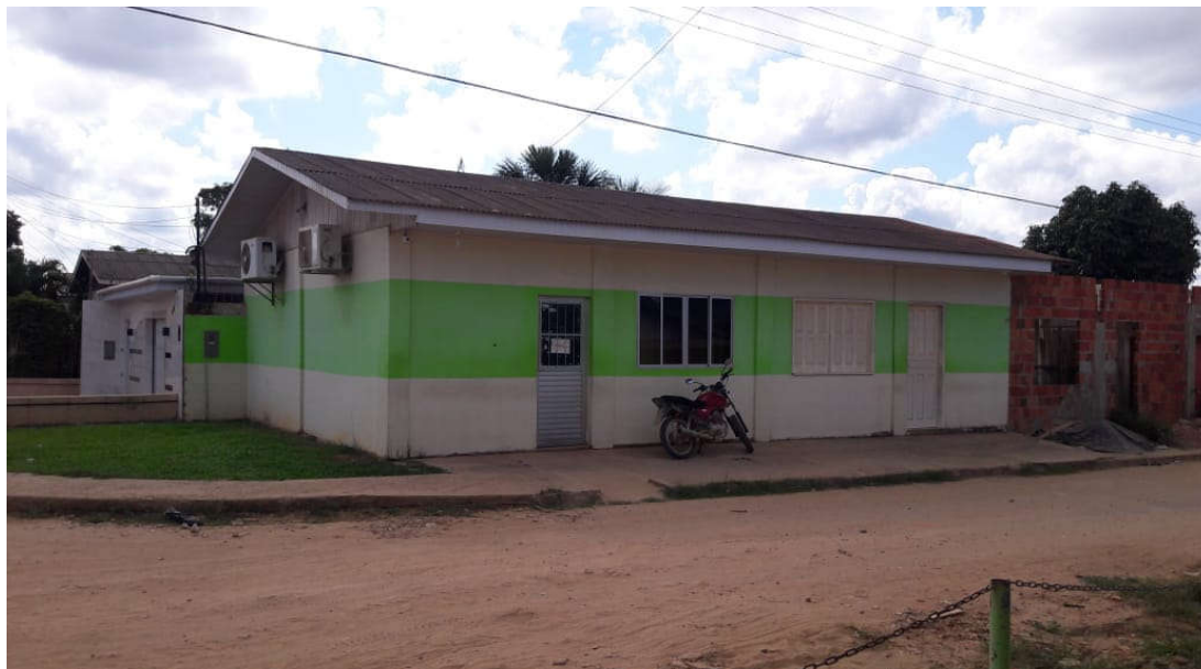
Figura 2 – Instalações provisórias do IFAM Campus Eirunepé (anexo I ao prédio Liceu), situado na rua Otaviano Melo, s/nº, Bairro Nossa Senhora de Fátima
