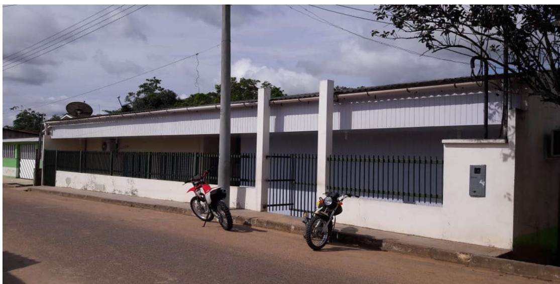
Figura 5 – Instalações provisórias do IFAM Campus Eirunepé / Centro de Referência em Inclusão e Tecnologia Social, situado na Rua Monsenhor Coutinho, s/nº, Bairro Nossa Senhora Aparecida
