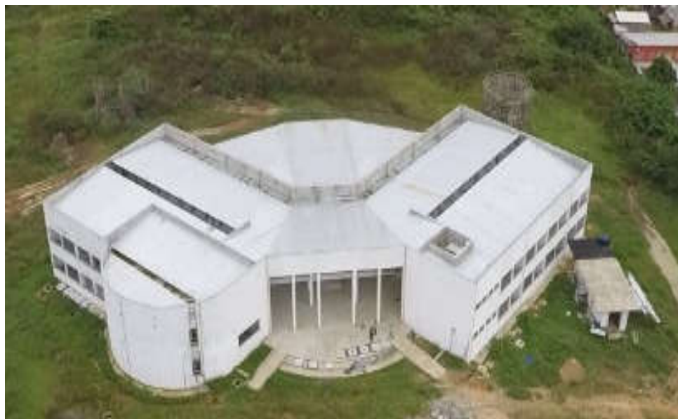
Figura 6 – Sede definitiva do IFAM Campus Eirunepé (em construção), situada na Avenida Prefeito João Cavalcante, s/nº, Bairro Nossa Senhora de Fátima
