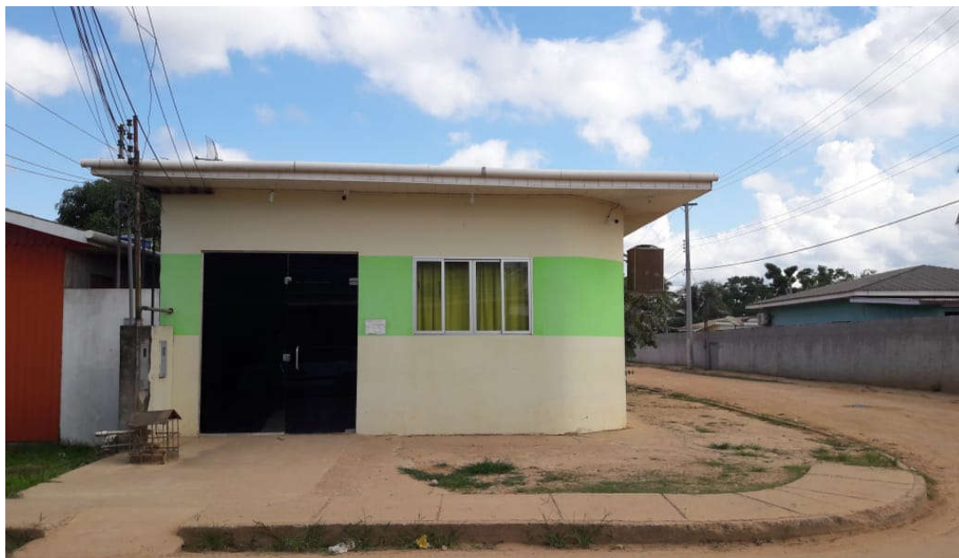
Figura 3 – Instalações provisórias do IFAM Campus Eirunepé (anexo II ao prédio Liceu), situado na rua Otaviano Melo, s/nº, Bairro Nossa Senhora de Fátima
