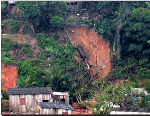
FIGURA 31. Deslizamento de terra
