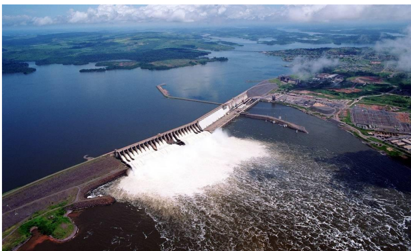
Figura 4 – Usina Hidrelétrica de Tucuruí
