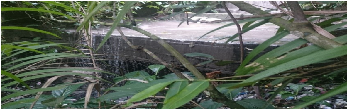
Escadaria do despejo de efluente da ETE vizinha
