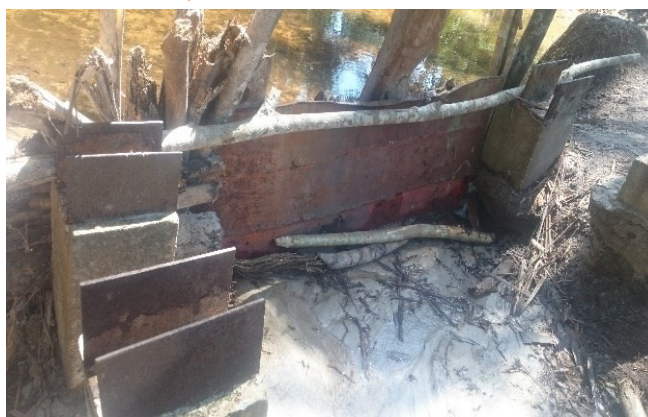
Barragem construída no lago formado pela nascente 01
